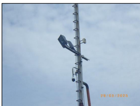
รูปที่ 2-37 การติดตั้งกล้องวงจรปิดบริเวณโดยรอบพื้นที่โครงการ
