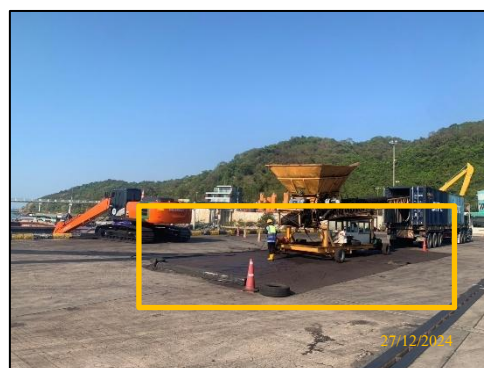
รูปที่ 2-18 การปูรองพื้นด้วยผ้าใบเพื่อเก็บรวบรวมสินค้าที่ร่วงหล่นจากสายพานลำเลียง
