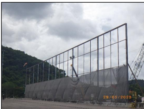
รูปที่ 2-9 การติดตั้งขั้วป้องกันและลดความแรงของลม
